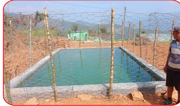
साना सिचाई पूर्वाधार निर्माण अन्तर्गत निर्माण भएका पक्क पोरखरी तथा पक्क कुलो निर्माण कार्यक्रम(जवा गा पा-३, नि न पा-५ )
