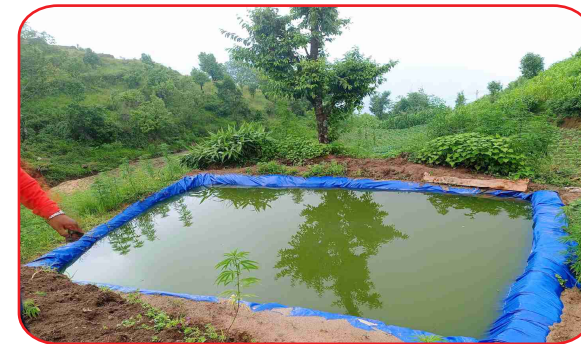
साना सिचाई पुर्वाधार निर्माण अन्तर्गत निर्माण भएका पक्कै कुलो तथा प्लाष्टिक पोखरी
